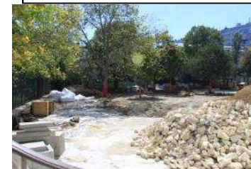
Finalisation du chantier à l'élémentaire Maryse Hilsz
