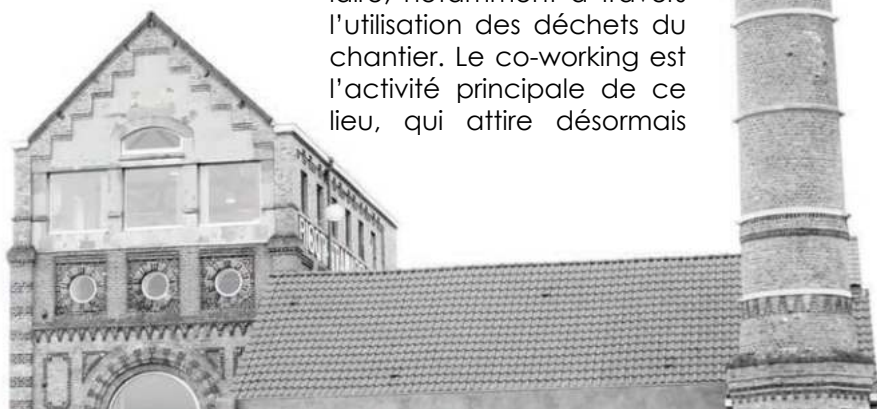
Les bâtiments de Work&Co, dans une ancienne manufacture réaménagée.
