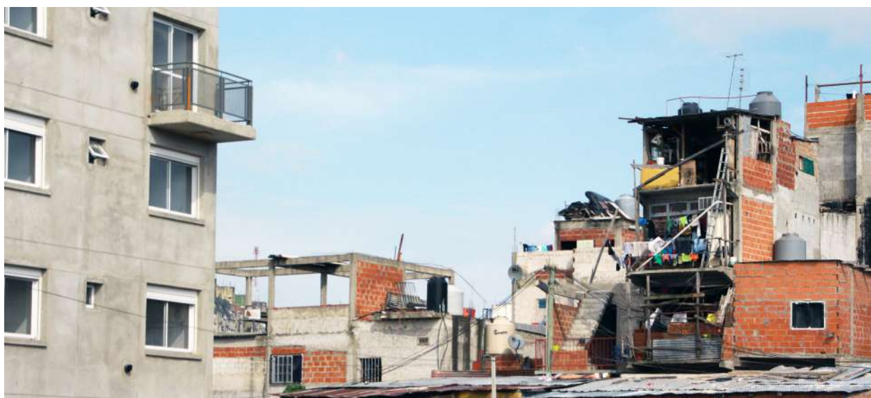
Photographie Villa 20 : à gauche le projet de relogement situé à proximité immédiate des établissements précaires existants à droite.
