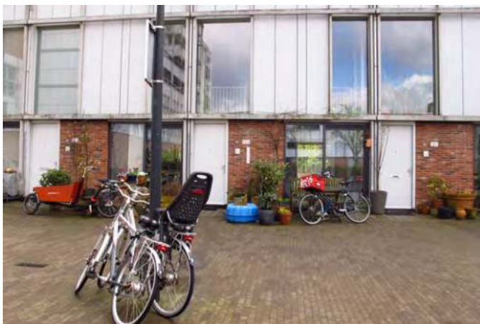
Figure 5 dans l'intérieur des îlots de logements
