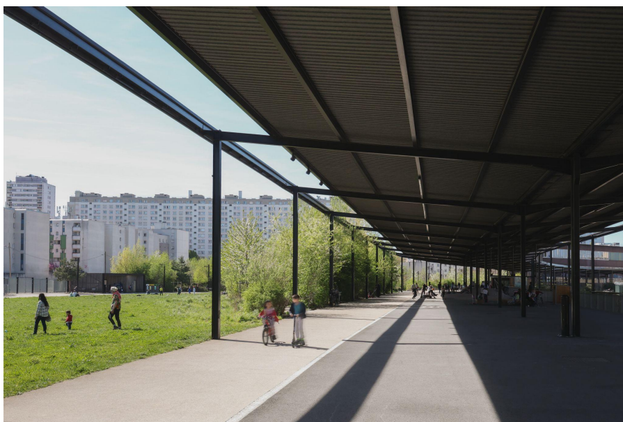
Parc Chapelle Charbon réalisé dans le cadre de l'opération de renouvellement urbain.
