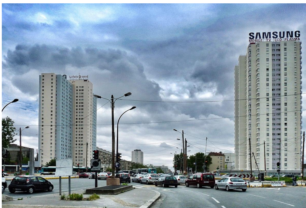
Vue des deux tours de Porte de la Chapelle depuis le boulevard périphérique.
