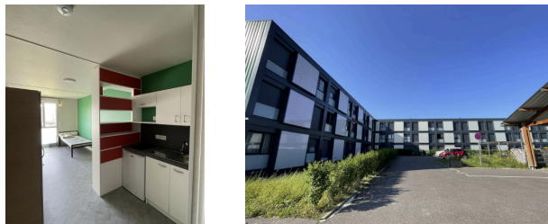
Photos de l'opération de BHS à Antony - à gauche : intérieur d'un module hors-site 3D (studio de la pension de famille) / à droite : vue d'ensemble de l'opération © Maurane Cherfi
