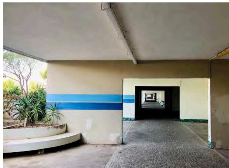
Fig. 1 - Succession de portiques au rez-de-chaussée
