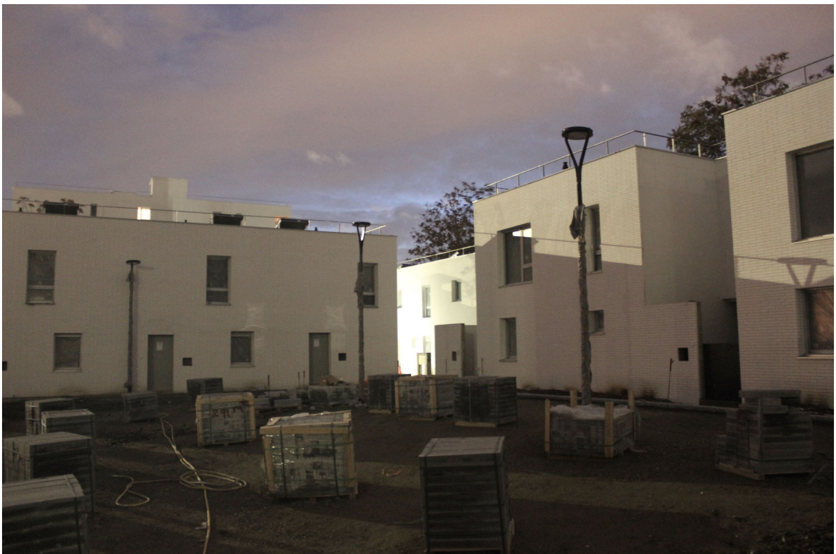
Figure 8 – Photo prise aux abords du passage Boisé
