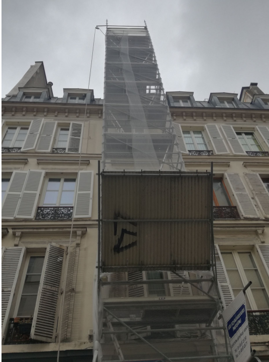
Rénovation du 33 rue de Seine. source : production personnelle
