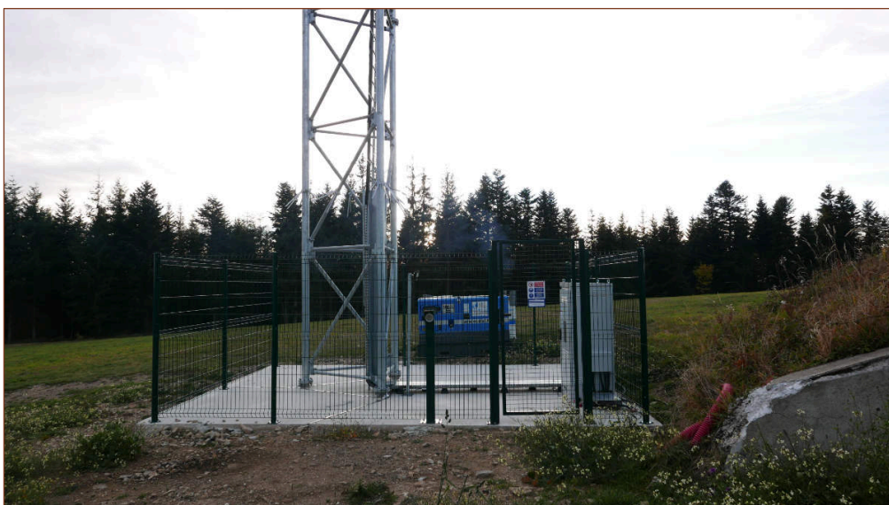
Fig 7 – Site de station 4G alimentée par une génératrice à défaut de raccordement électrique en Ardèche
